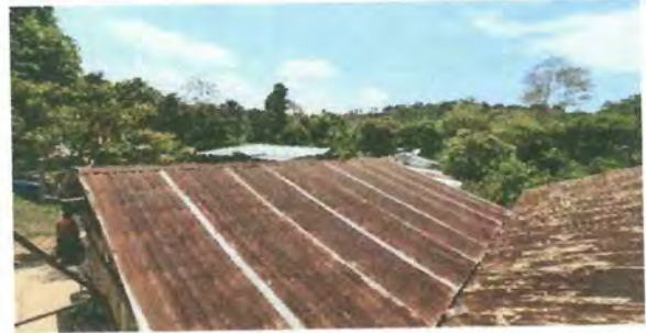
Foto 2: Se observa el deterioro del techo y desprendimiento del capo de los modulos 2
